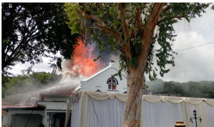
Penanganan kasus kebakaran Gedung Pusat Kebudayaan di Sawahlunto
