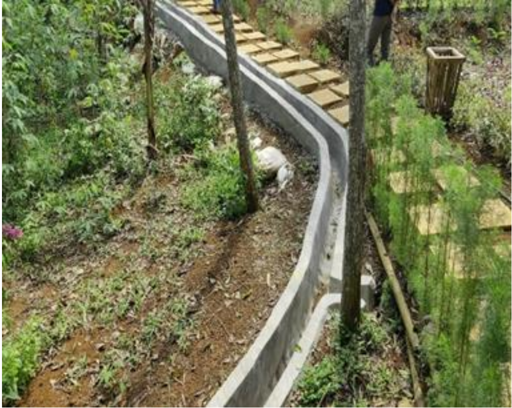
Pekerjaan saluran air sisi timur situs
