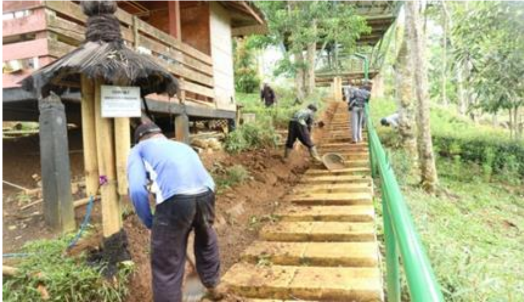
Pekerjaan drainase teras 5
