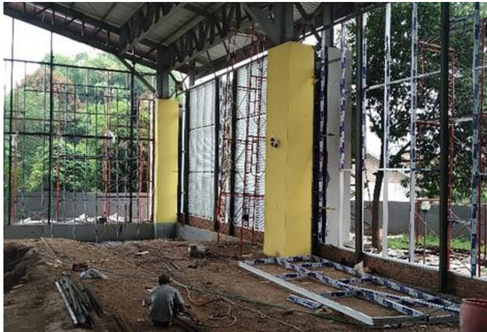
Pembuatan Bangunan Pelindung Sitis Sumur Upas Tahap II
