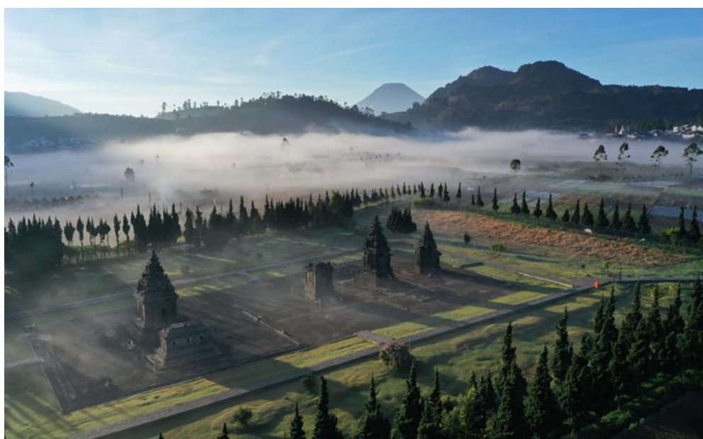
Pendokumentasin kompleks Candi Arjuna
