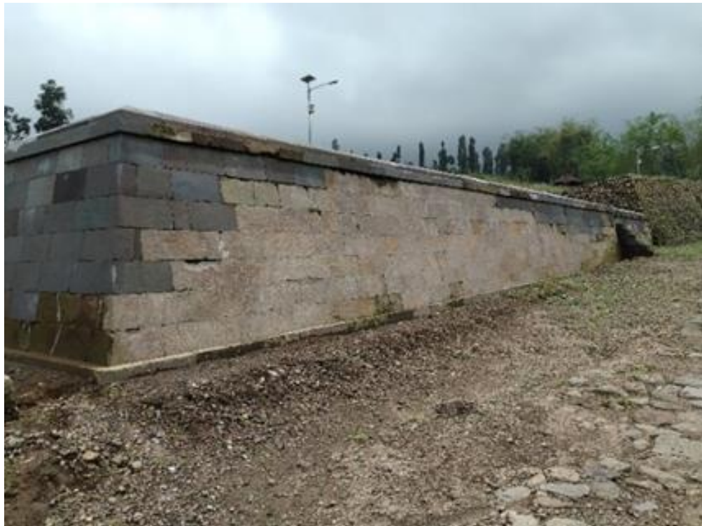
Hasil Pekerjaan Restorasi Talud Bolder
