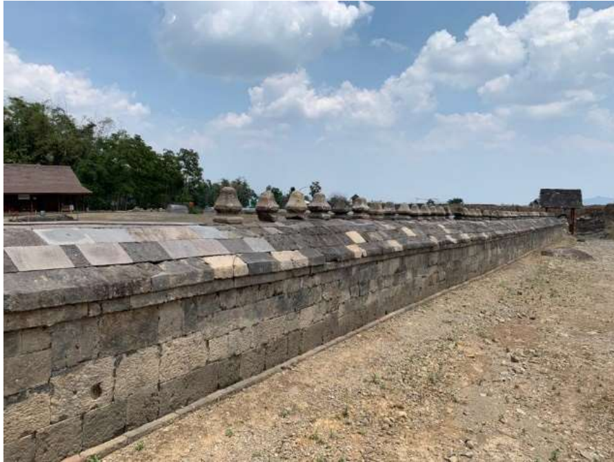
Kondisi terakhir situs Liyangan setelah selesai dilaksanakan pekerjaan 2019
