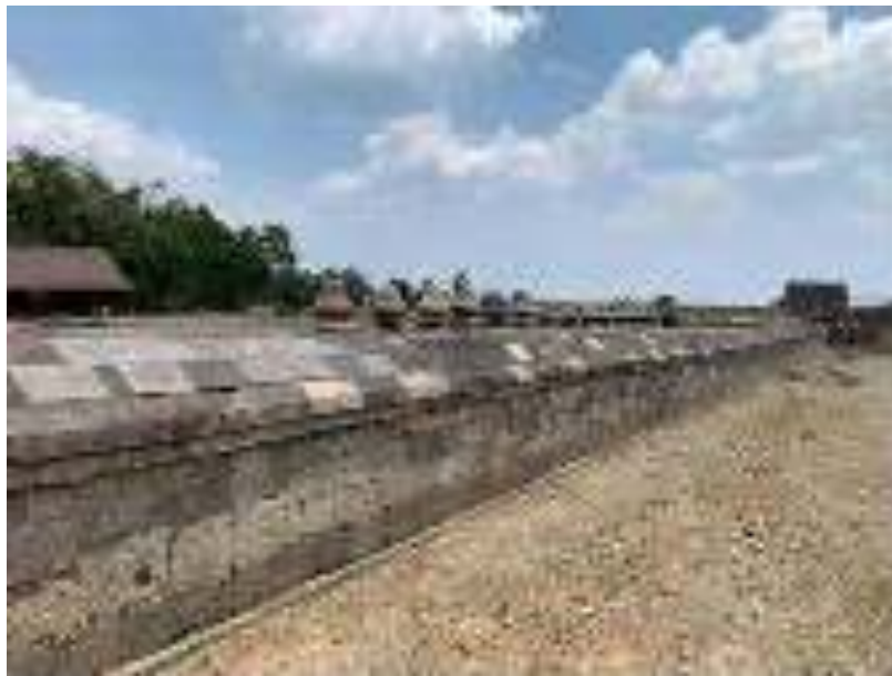
Gambar 38. Hasil Pemugaran Talud Dinding
