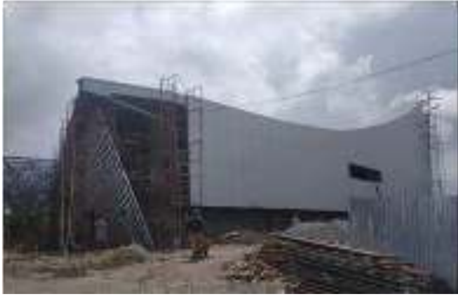
Gambar 54. Gedung Museum dari Sisi Kanan
