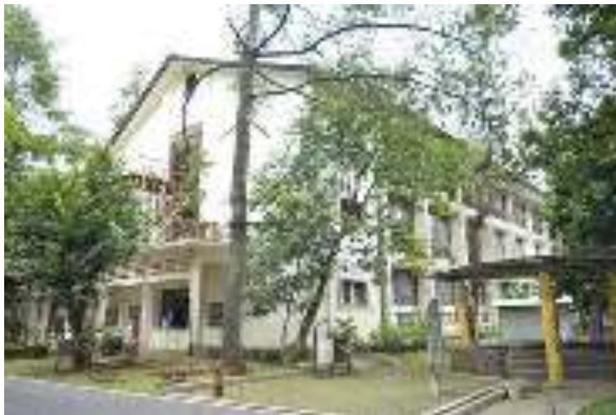
Gambar 37. Bangunan Prefab Kimia ITB yang akan dibongkar
