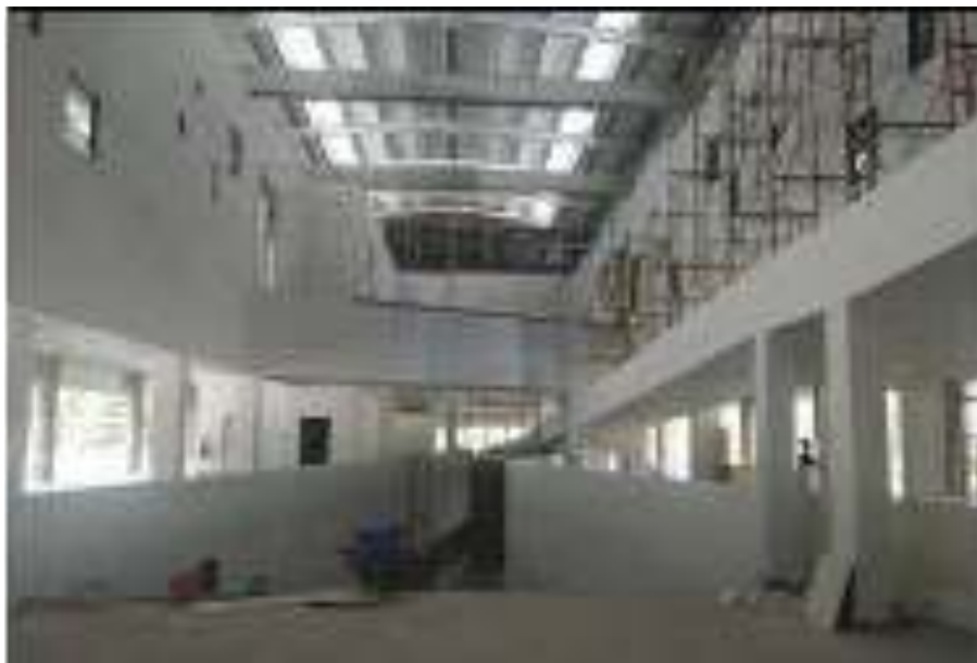
Gambar 53. Gedung Museum (area tengah lantai satu)
