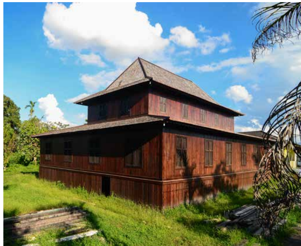
Bangunan Rumah Dalam yang berada diutara atau bagian belakang dari Keraton Pakunegara Tayan. Rumah Dalam ini adalah bangunan baru yang seluruhnya terbuat dari kayu ulin
