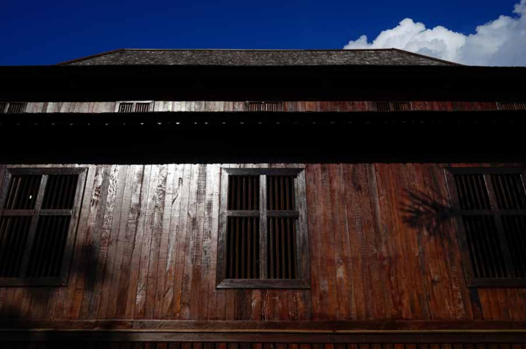
Bangunan Rumah Dalam yang berada diutara atau bagian belakang dari Keraton Pakunegara Tayan. Rumah Dalam ini adalah bangunan baru yang seluruhnya terbuat dari kayu ulin
