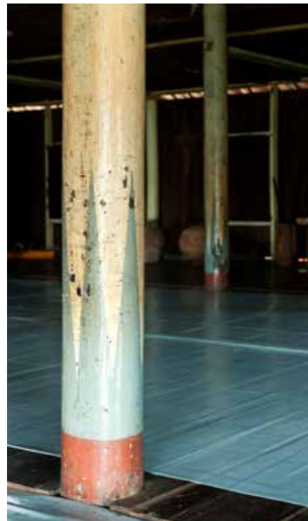
Tiang bulat yang terbuat dari kayu ulin tampak berfungsi sebagai penyanggah bangunan dari lantai bangsal hingga atap Corak pada tiang-tiang ini masih asli dan diwarnai dengan pewarna yang menggunakan bahan dasar getah pepohonan.
