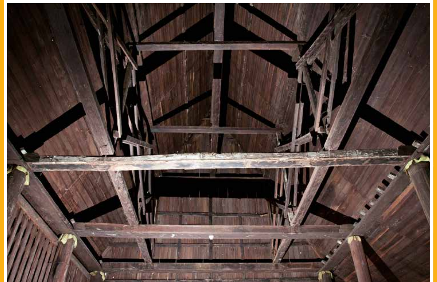
Konstruksi atap bangunan Rumah Bosar terdiri dari tang-tiang bulat menyanggah hingga ke atap dan rangkaian kayu menopang atap yang bagian dalam tertutup kayu dan keseluruhan bahan dari bangunan ini terbuat dari kayu ulin.
