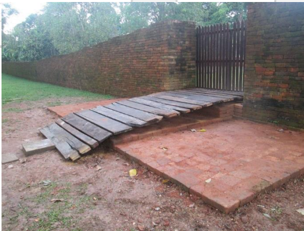
Foto 10. Lantai Tangga Masuk Sisi Selatan
