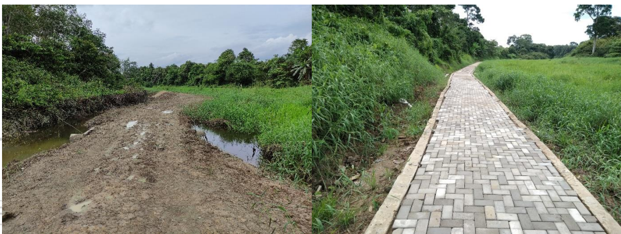
Foto 20-21. Kondisi Sebelum dan Sesudah Pembuatan Jalan Setapak
