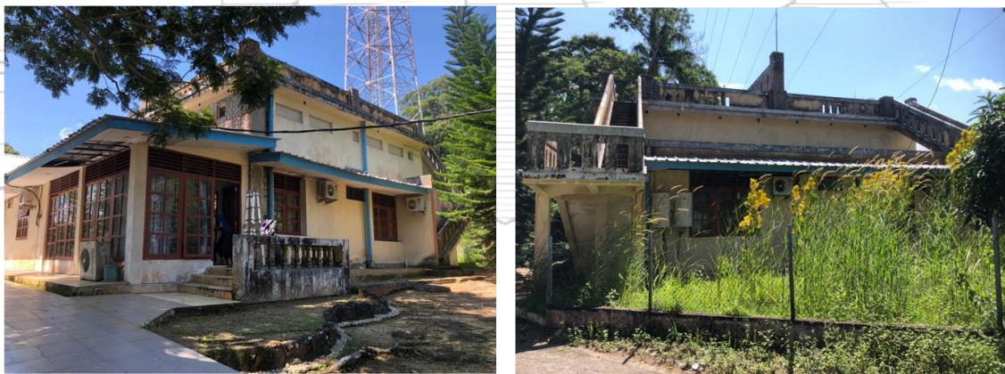
Foto 14-15. Bangunan Pavilliun I dengan Teras Tambahan dan Lantai 2 yang masih asli
