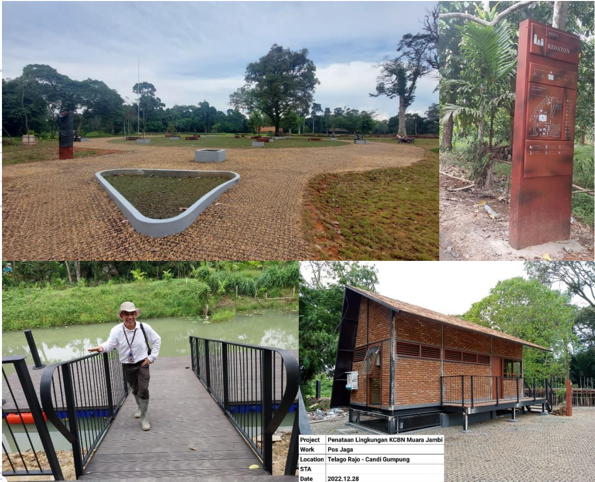
Foto 26-29. Hasil Pekerjaan Penataan Lingkungan
