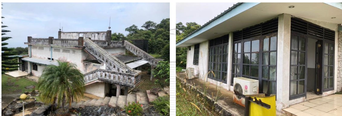
Foto 16-17. Bangunan Pavilliun II dengan Lantai 2 yang masih asli dan Teras Tambahan
