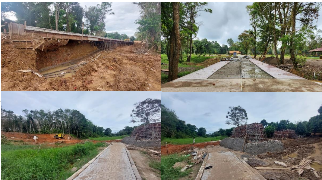
Foto 22-25. Proses Pembuatan Jembatan Kanal Sungai Jambi dan Kedaton
