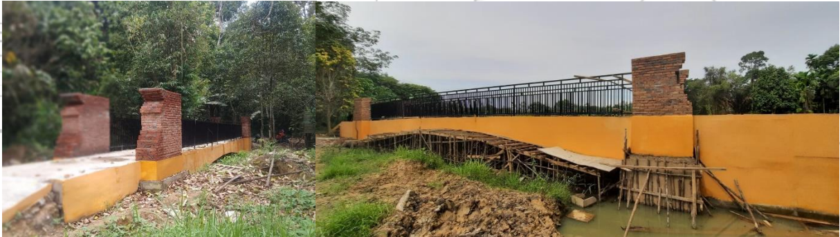
Foto 19. Jembatan Parit Johor
