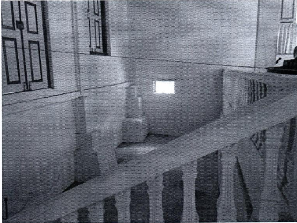
(Sumber: https://firstychrysant.wordpress.com , diakses Tahun 2017) Foto 5. Sisa Kolong Rumah yang Tidak Ditimbun.
