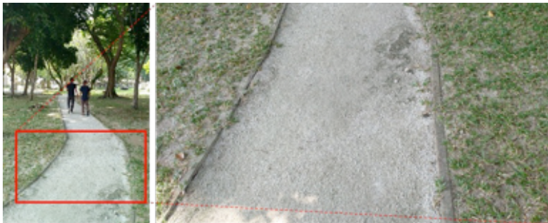
Contoh penggunaan konstruksi jalan setapak dengan bahan bubuk kapur karang dan pasir yang dipadatkan, digunakan di kompleks Protestant Cemetery George Town, Penang-Malaysia.
