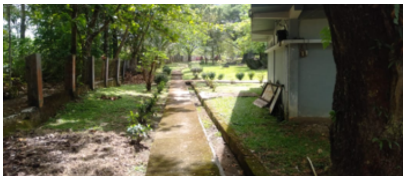
Salah satu drainase yang mengalirkan genangan air dari zona taman batu
