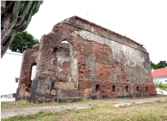
Foto 3. Struktur H Benteng Balangnipa (Dokumentasi BPCB Sul-Sel)
