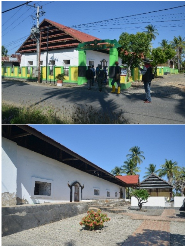
Foto 21. Kompleks Makam La Patau Matanna Tikka (Nagauleng) tampak depan (barat) & halaman kompleks bagian selatan (kiri). Dok. BPCB Sulsel 2019
