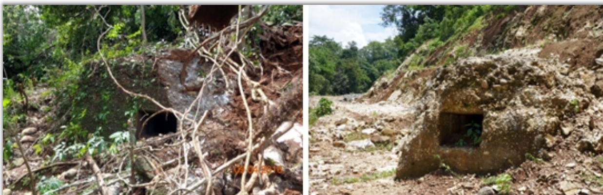
Gambar 2. Foto Bunker 1 (Pillboks): kondisi pada saat pembersihan lahan, pertama kali diberitakan sebagai temuan tahun 2016 (kiri, sumber foto: dokumentasi Kantor Direksi PT. Wika-Hutama), dan kondisi ketika tim kajian melakukan peninjauan dan survey Februari 2017 (kanan)
