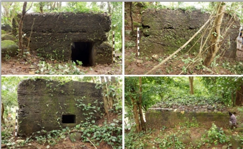
Gambar 3. Bunker 2 (Baterai): Tampak dari arah timur dimana pintu masuk berada (Foto kiri atas), dinding bagian selatan (kanan atas), jendela bidik pada dinding barat (foto kiri bawah), dan dinding sebelah selatan yang sebagian tertutup dengan material tanah, dan tampak permukaan atas yang dikamufilase dengan boulder-boulder batu (foto kanan bawah).
