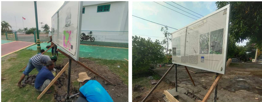
Dokumentasi Pemasangan Papan Informasi dan Papan Larangan
