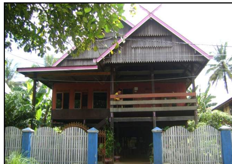
Foto 1. Bentuk rumah panggung Suku Bugis di Barru, Sulawesi Selatan. Hand print ditempelkan pada bagian dinding luar, tiang, ruang tamu dan ruang dapur (Sumber: Koleksi penulis).
