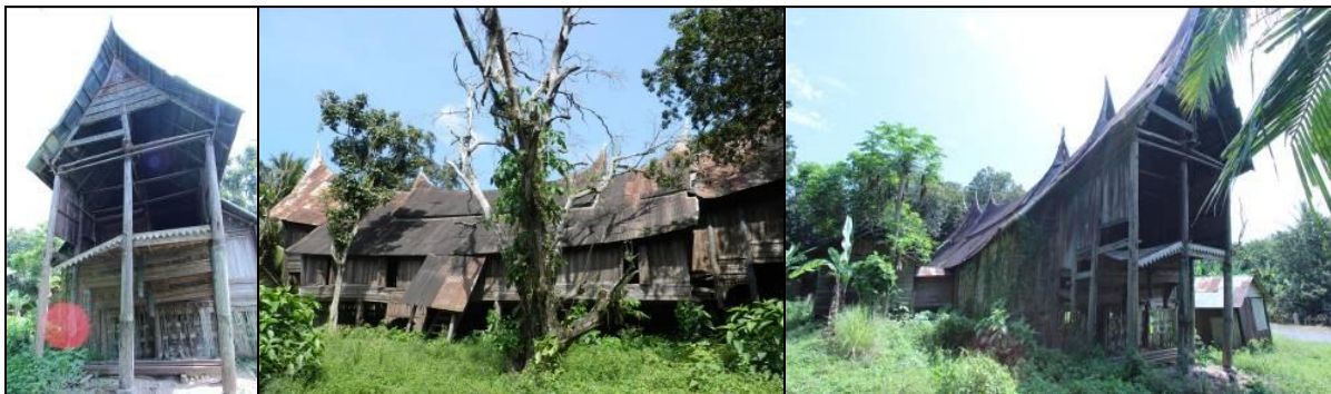
Salah satu bangunan rumah gadang di Nagari Sumpur Kab. Tanah Datar Sumbar Rumah gadang ini sudah tidak dihuni lagi, bangunan yang ada masih menunjukkan kemegahan rumah gadang ini di masanya.
