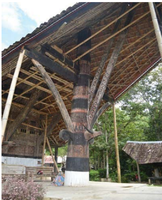
Foto 7. Papan pamiring longa baru yang tidak diukir dan fototiang Penulak yang mengalami kemiringan (Sumber: Penulis, 2015)
