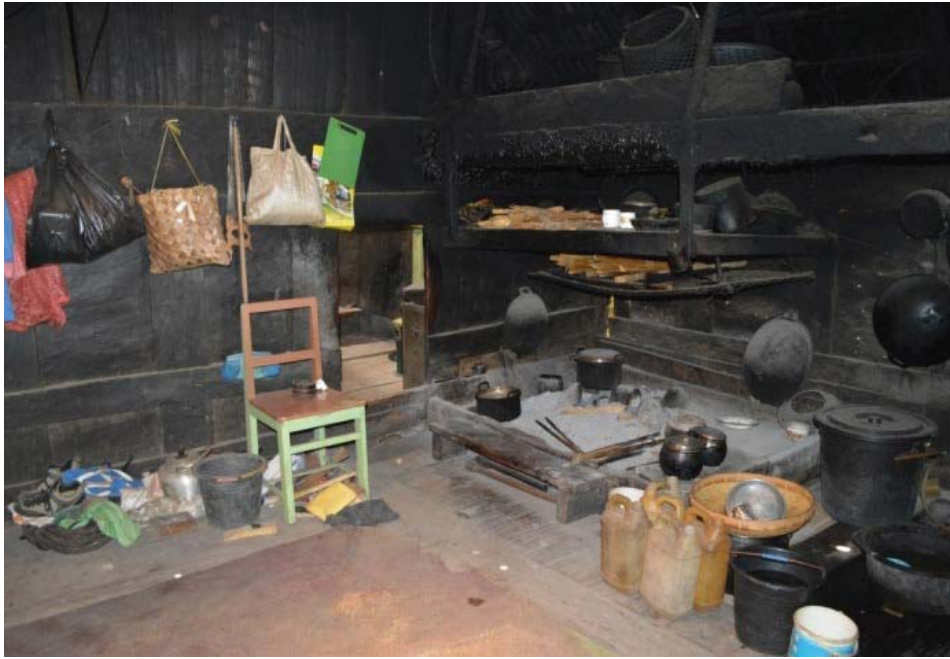
Foto 6. Bagian dapur yang dindingnya mengalami perubahan warna (Sumber: Penulis, 2016)
