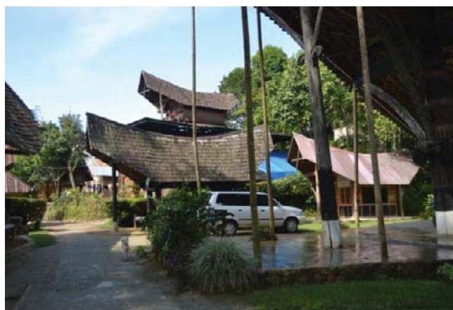
Foto 5. Bagian atap yang telah diganti dengan seng yang berdampak pada derajat keaslian dari Banua Layuk Rambu Saratu (Sumber: BPCB Sulawesi Selatan, 2014)
