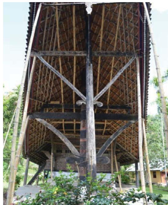
Foto 7. Papan pamiring longa baru yang tidak diukir dan fototiang Penulak yang mengalami kemiringan (Sumber: Penulis, 2015)
