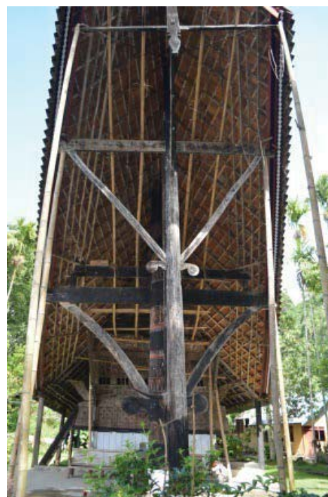
Foto 3. Tiang penulak dan pesodok banua tampak depan dan para-para yang berada di samping kiri (Sumber: Penulis, 2015)
