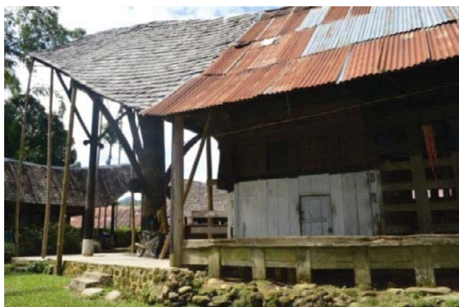
Foto 5. Bagian atap yang telah diganti dengan seng yang berdampak pada derajat keaslian dari Banua Layuk Rambu Saratu (Sumber: BPCB Sulawesi Selatan, 2014)
