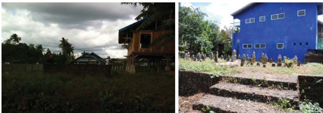
Gambar 12. Bangunan Baru disekitar Kompleks Makam (dok. Dewi Susanti,2012)
