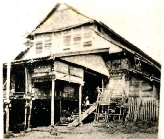
Gambar 9. Bangunan Kamali Kara (bangunan asli)
