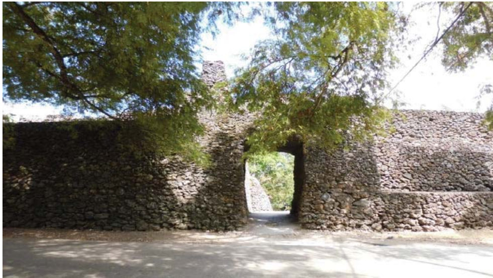
Gambar 1. Pintu gerbang (Lawana) Lantogau, salah satu lawa di benteng sisi barat (dok. BPCB Sul-Sel, 2012)
