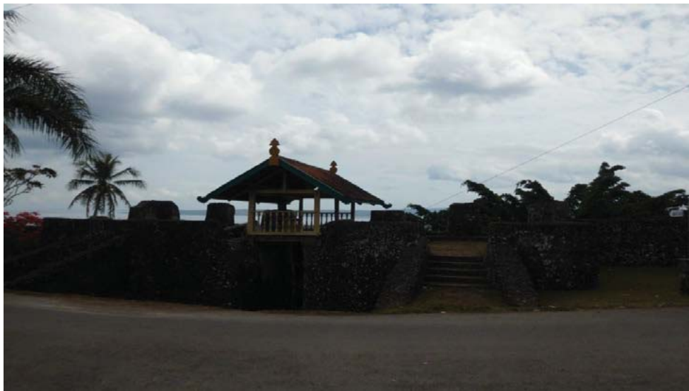
Gambar 2. Pintu gerbang (Lawana) Lanto, salah satu lawa di benteng sisi utara (dok. BPCB Sul-Sel, 2012)
