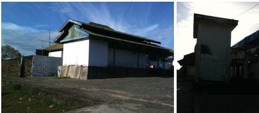
Gambar 11. Bangunan tambahan pada bangunan Masjid Keraton Buton (dok BPCB Sul-Sel, 2012)
