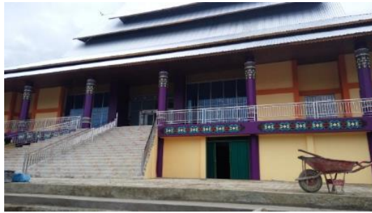
Kondisi bagian depan setelah selesai.
