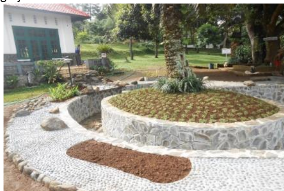
Kolam dan pembuatan sumur sebagai sumber air untuk Bangunan Cagar Budaya Linggarjati.
