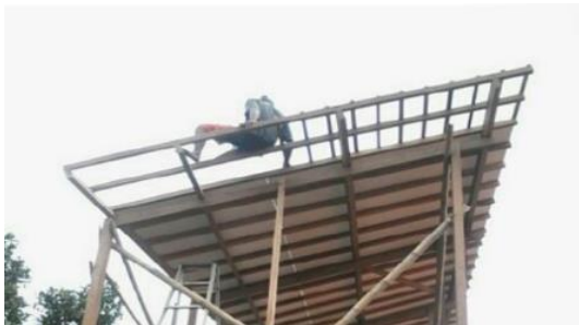
Pemasangan Plafon GRC dan Reng
