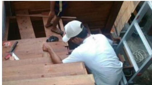
Pekerjaan Pemasangan Papan Anak Tangga
