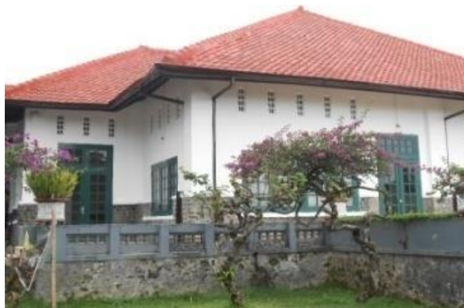
Kondisi Bangunan Cagar Budaya Linggarjati setelah selesai direvitalisasi.
