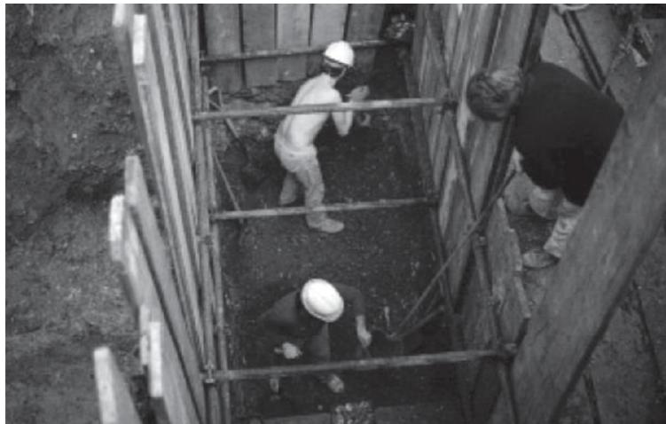
Foto 8. Sistem keamanan kerja pada saat ekskavasi (Sumber buku Fiekd Archaeology halaman 84)
