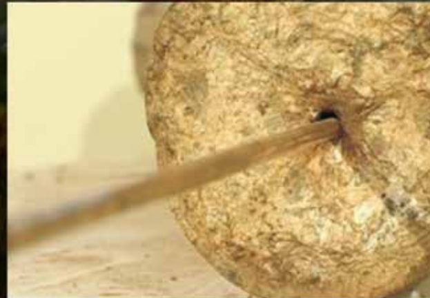
Pemasangan angkur untuk penguatan
