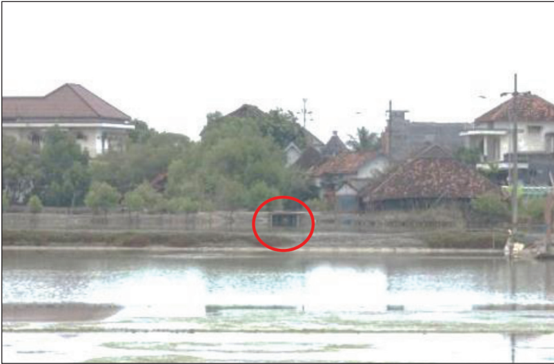
Foto 11. Pintu air ( sluis ) yang berfungsi menahan air ketika air laut surut (Dokumentasi: Tim Peneliti BPNB DIY, 2017).
