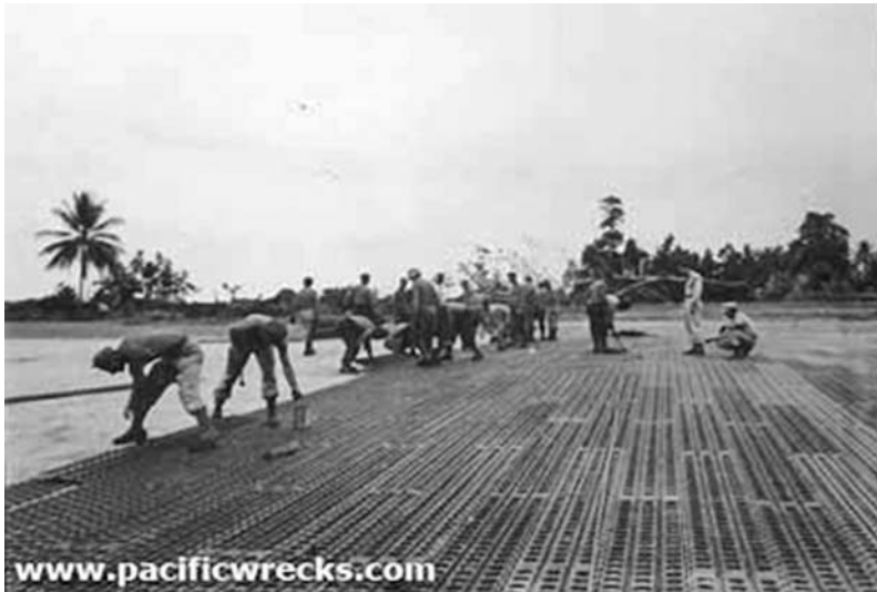
Para pekerja yang sedang mengerjakan lapangan terbang dengan menyusun tikar baja sebagai landasan pesawat terbang.
