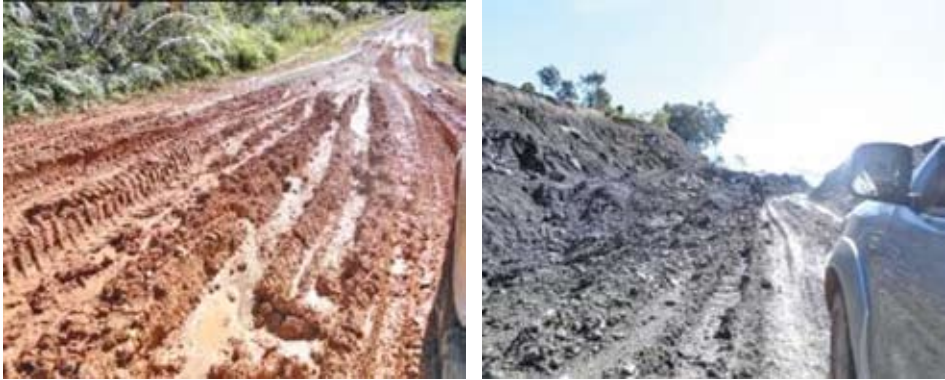
Gambar 11. Kondisi Jalan dari Sorong menuju Sausapor Sumber : Tim Sausapo BPNB Jayapura
