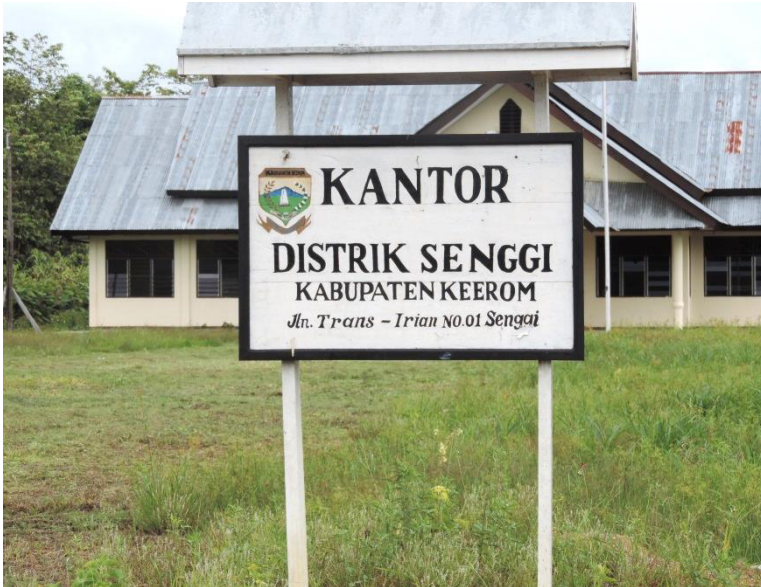
Gambar 4 : Kantor Distrik Senggi
