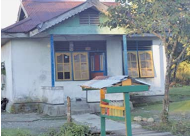
Gambar 5. Rumah Permanen Sumber : Dokumentasi Tim, 2013
