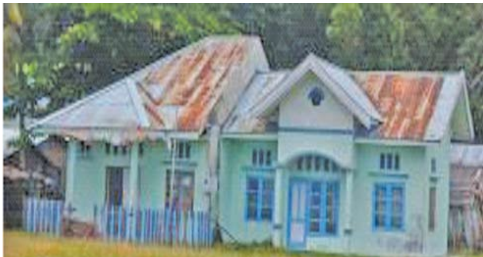
Gambar 20: Bangunan PUSTU Kampung Fafanlap Sumber: Dokumentasi Tim, Mei 2013
