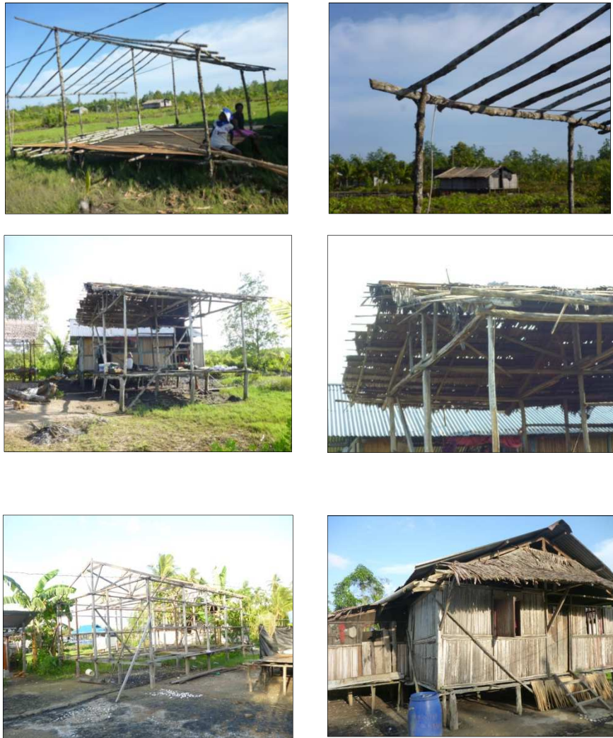
Gambar 39. Struktur konstruksi Rumah Inanwatan Sumber : Dok. Tim, 2014
