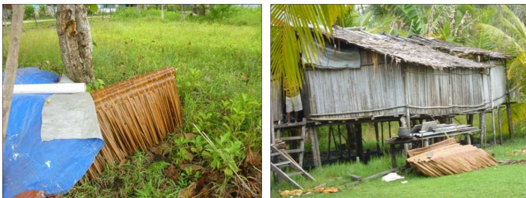
Gambar 38. Proses pengeringan daun sagu yang dianyam sebagai konstruksi penutup atap
