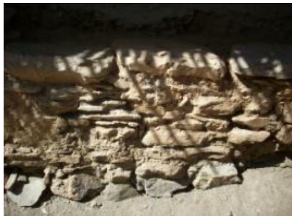
Gambar 4 Lutur (susunan batu)
