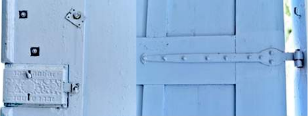
Foto 10. Bagian Pintu Bangunan Museum Mandar Majene
