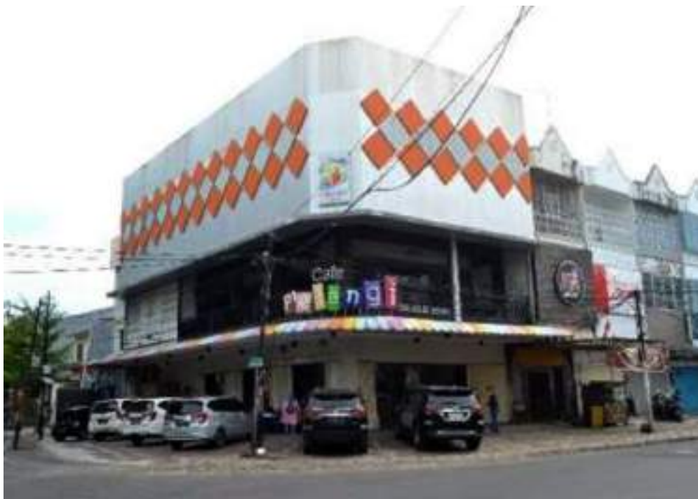
Foto 4. Tampak Utara Bijenkorf. Dok. BPCB Prov. Sulsel, 2021
