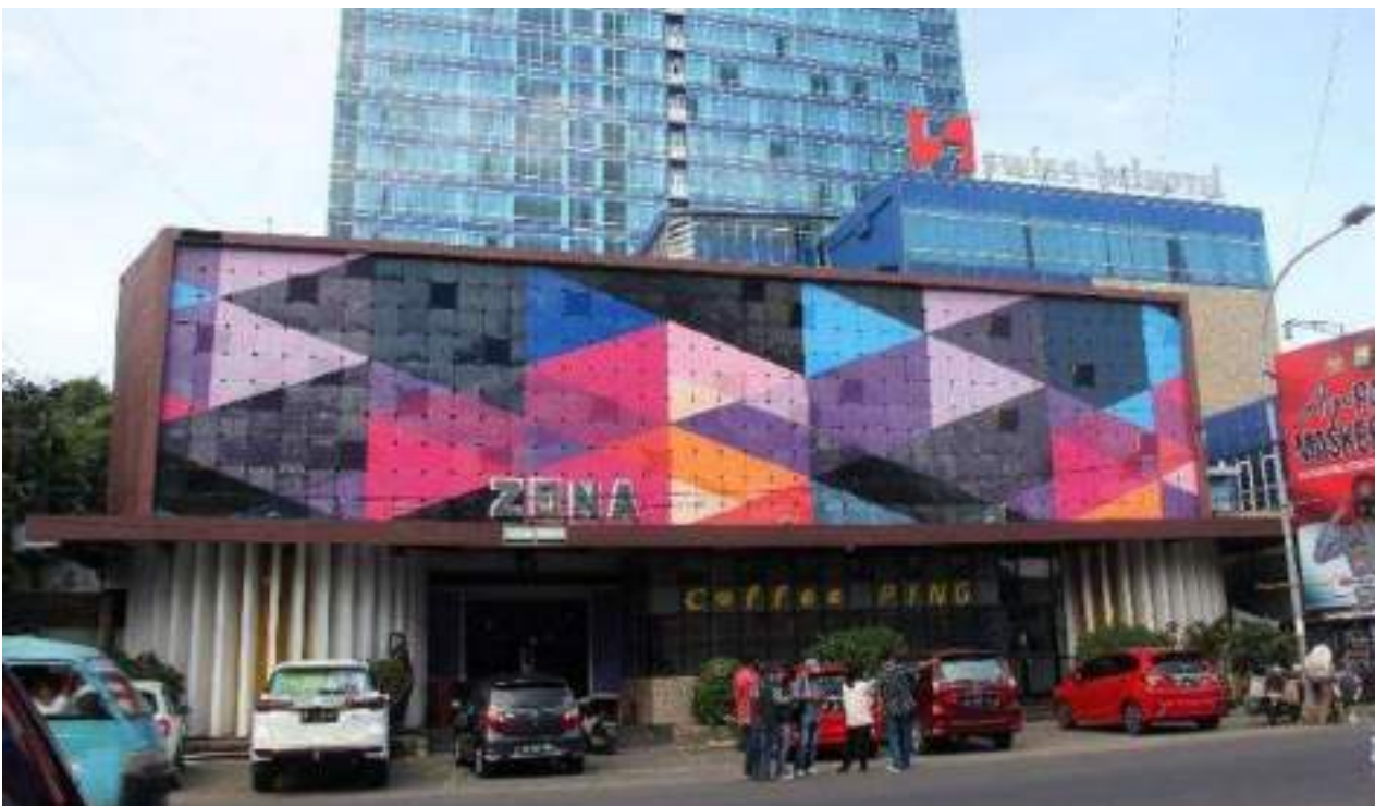
Foto 1. Tampak luar bangunan Zona Café. Dok. BPCB Prov. Sulsel, 2021.
