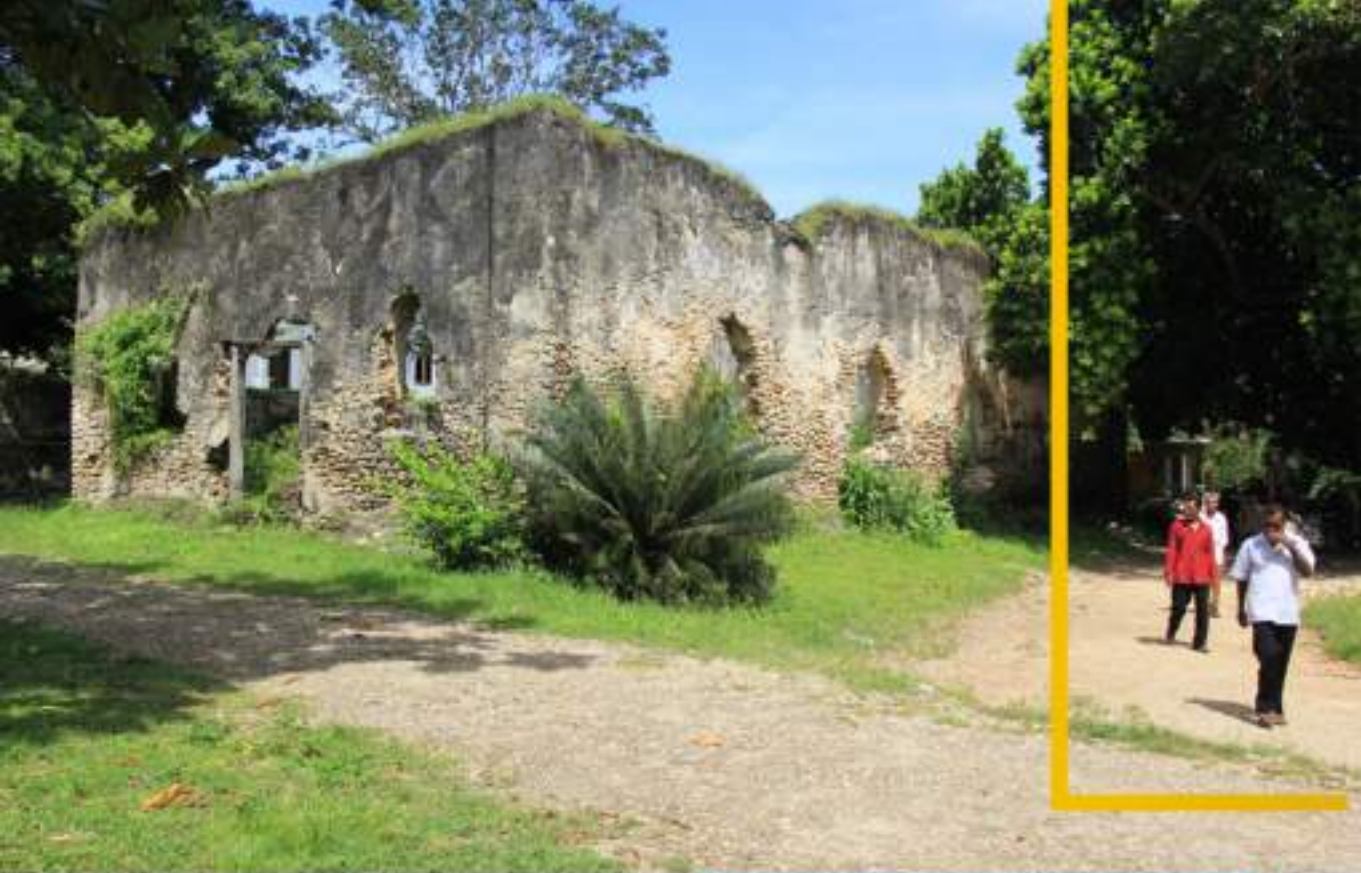
Foto: sisa bangunan Gereja wonreli (2) (Dok. BPCB Malut, 2017)
