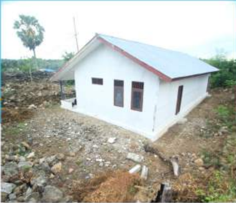
Foto: Bangunan bekas kantor desa (Dok. BPCB Malut, 2017)
