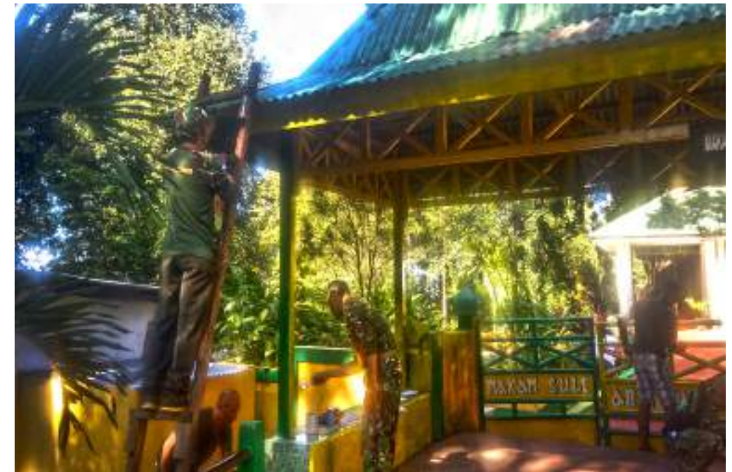
Foto 7. Perbaikan dan pengecatan pintu gerbang Makam Sultan Baabullah (Sumber: Korem 152/Babbullah, 2021)
