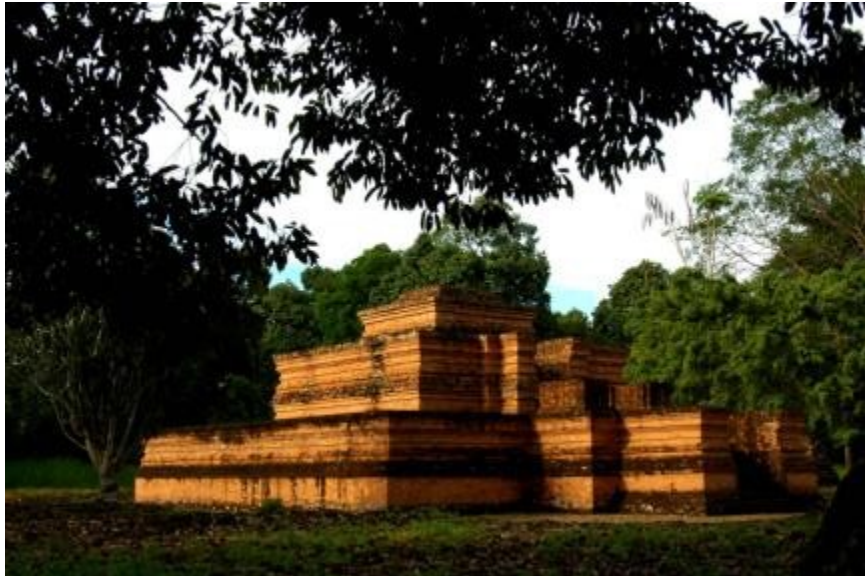
Bangunan tanpa beratap
