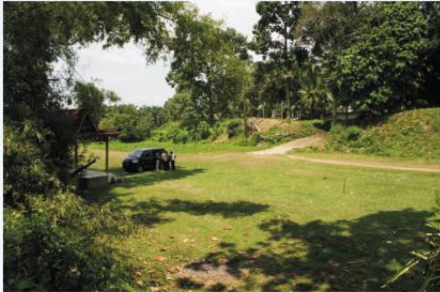
Salah satu tanggul Benteng Tujuh Lapis Dalu-Dalu Koleksi BPCB Prov. Sumbar, Riau dan Kepri
