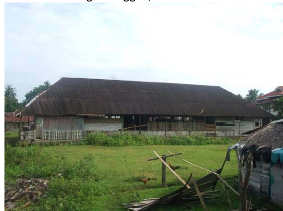
Salah satu bangunan gudang yang masih tersisa
