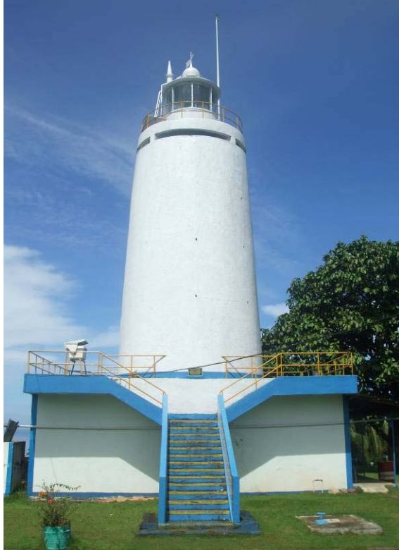
Bangunan menara sura Bukit Lampu
